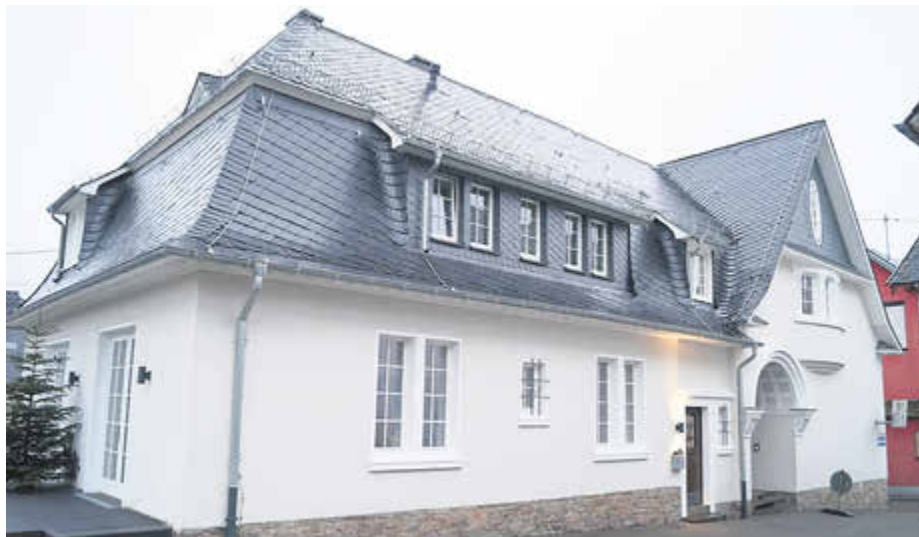
Die ehemalige Schule in Waldweiler wurde aufwendig restauriert.
