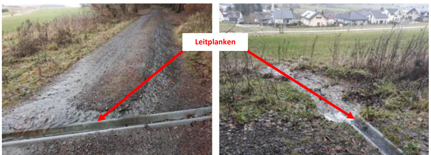
ABBILDUNG 27: ENTWÄSSERUNG DES WALDWEGES ÖSTLICH DES NEUBAUGEBIETES
