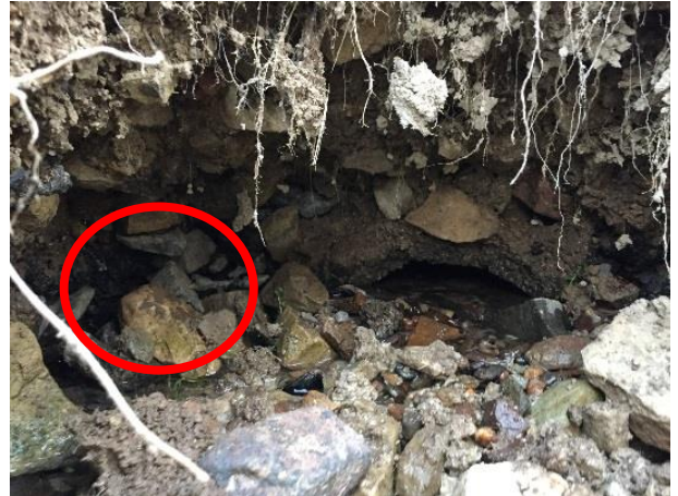
ABBILDUNG 15: VERROHRUNG AM ÖSTLICHEN ENDE DES GRABENS
