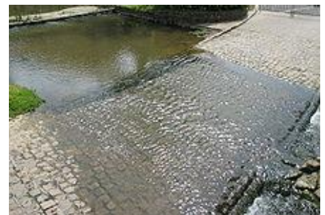
ABBILDUNG 25: FURT MIT PFLASTERSTEINEN
