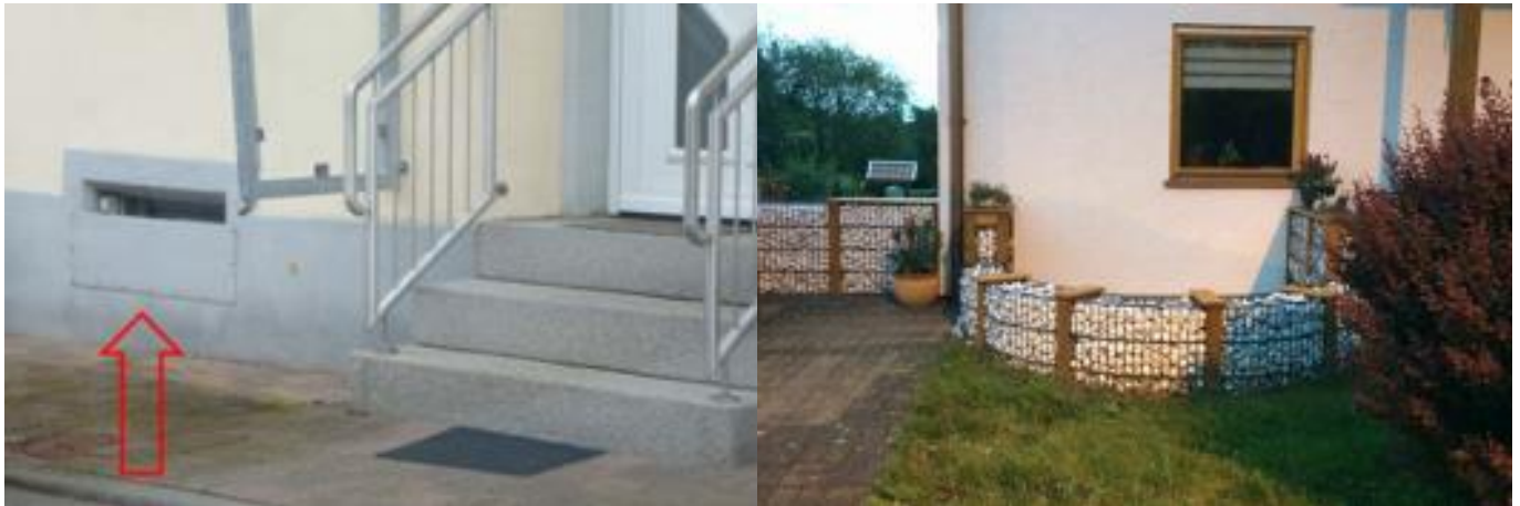
ABBILDUNG 31: GESICHERTE KELLERFENSTER (QUELLE: OBERMEYER PLANEN UND BERATEN GMBH)
