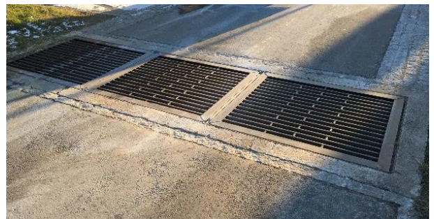
ABBILDUNG 28: BEISPIEL EINER BLEITFLÄCHIGEN REGENRINNE
