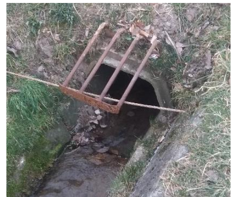
ABBILDUNG 17: GITTER VOR EINLAUF IN FARSCHWEILER BACH
