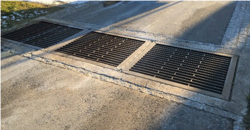
ABBILDUNG 16: BREITFLÄCHIGER EINLAUF IN L-EVERLINGEN (FOTO INCA, 2022)
