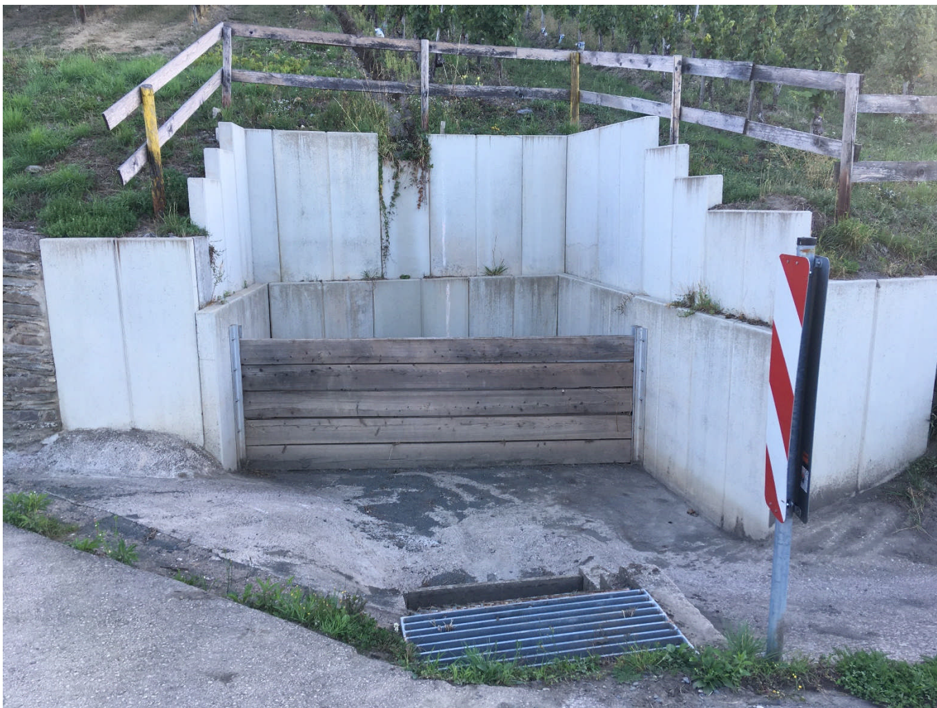
ABBILDUNG 17: SANDFANG EINES ABLEITUNGSGRABENS IN WALDRACH (FOTO INCA, 2021)
