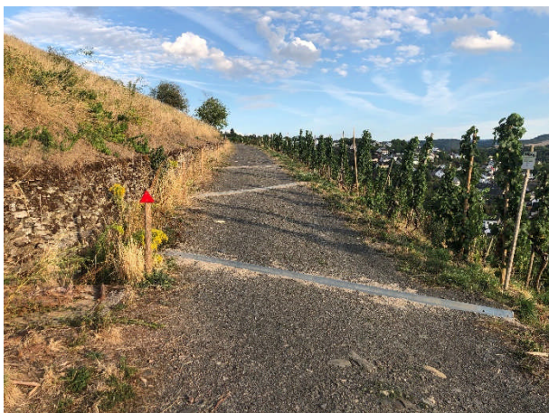
ABBILDUNG 23: MEHRFACHE KLEINRÄUMIGE WEGEABSCHLÄGE (FOTO INCA,03.09.2022)
