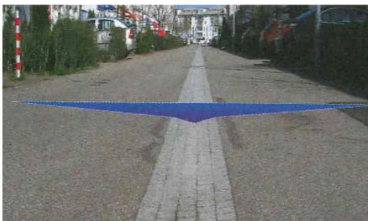
ABBILDUNG 28: STRAÙE MIT INVERSEM DACHPROFIL (DWA, 2013)
