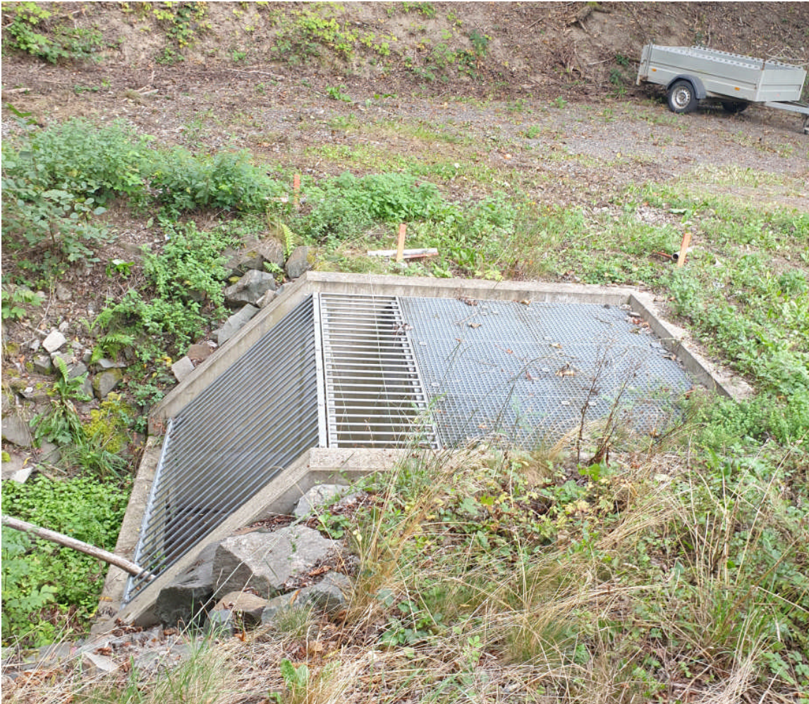
ABBILDUNG 19: HYDRAULISCH OPTIMIERTER EINLAUF IN KASEL (FOTO INCA, 2021)
