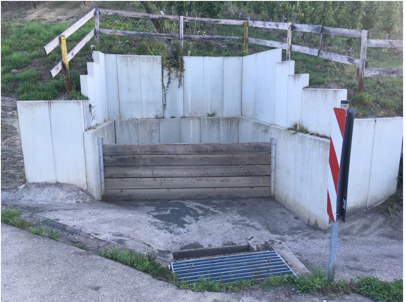
ABBILDUNG 17: SANDFANG EINES ABLEITUNGSGRABENS IN WALDRACH (FOTO INCA, 2021)
