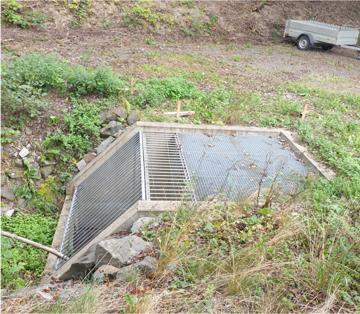
ABBILDUNG 19: HYDRAULISCH OPTIMIERTER EINLAUF IN KASEL (FOTO INCA, 2021)
