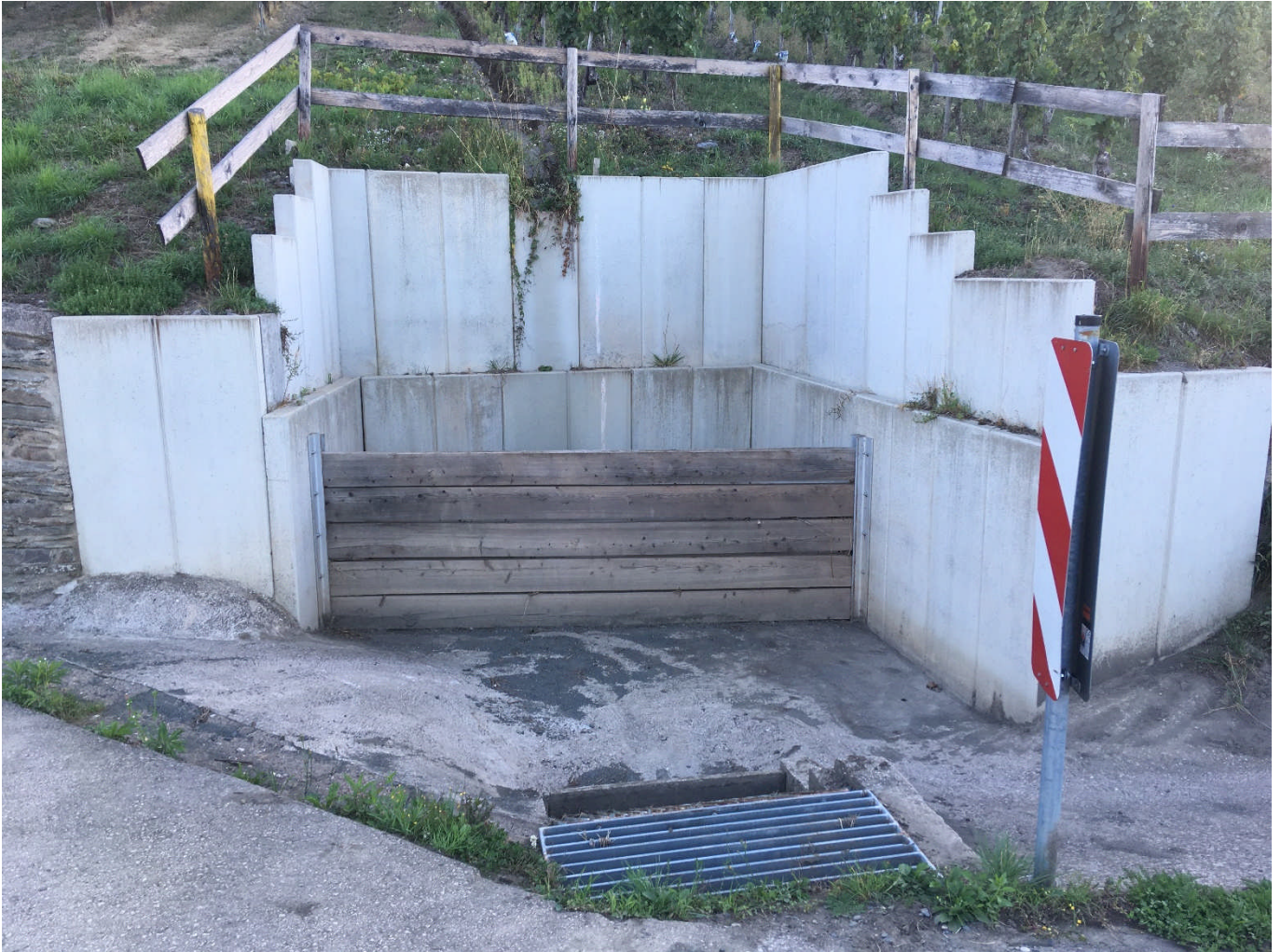
ABBILDUNG 17: SANDFANG EINES ABLEITUNGSGRABENS IN WALDRACH (FOTO INCA, 2021)
