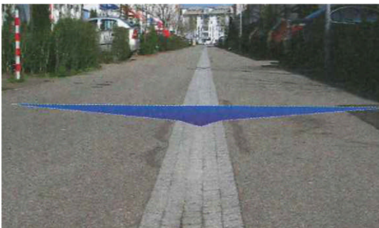
ABBILDUNG 32: STRAÙE MIT INVERSEM DACHPROFIL (DWA, 2013)
