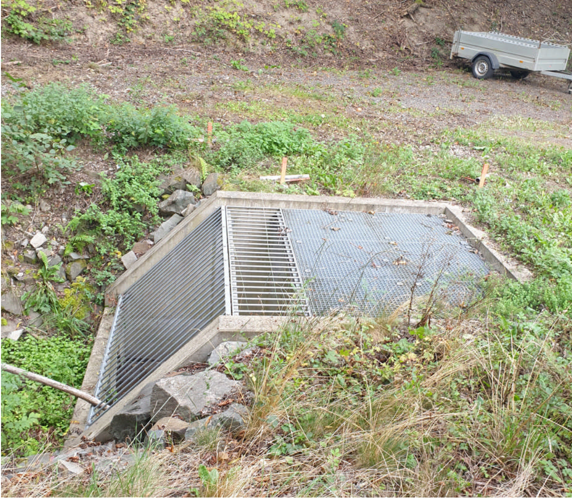
ABBILDUNG 23: HYDRAULISCH OPTIMIERTER EINLAUF IN KASEL (FOTO INCA, 2021)
