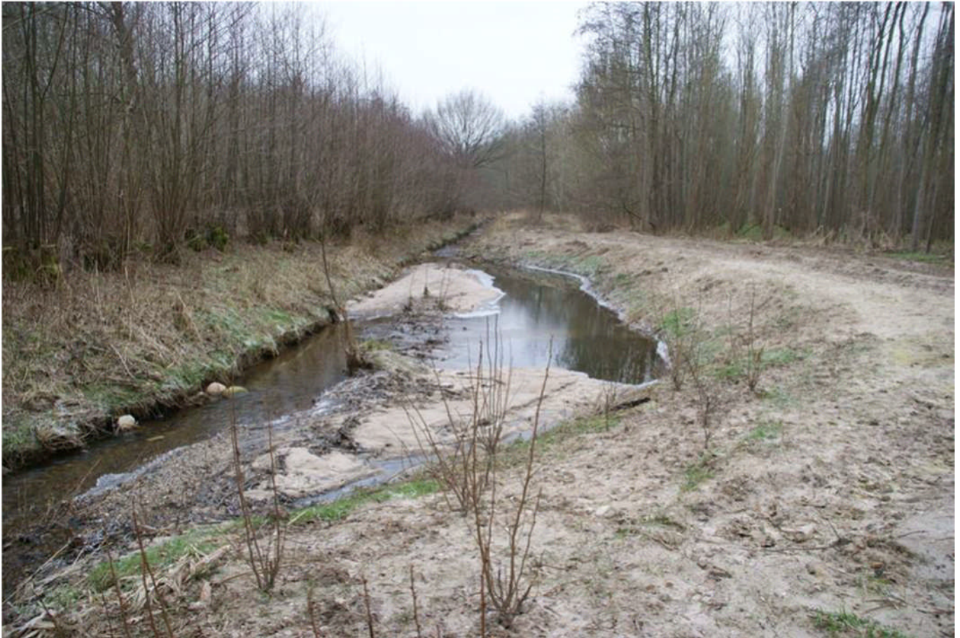
ABBILDUNG 23: SANDFANG AN DER OHLAU (SCHLESWIG-HOLSTEIN) (GEWÄSSERPFLEGEVERBAND OHLAU 2014)
