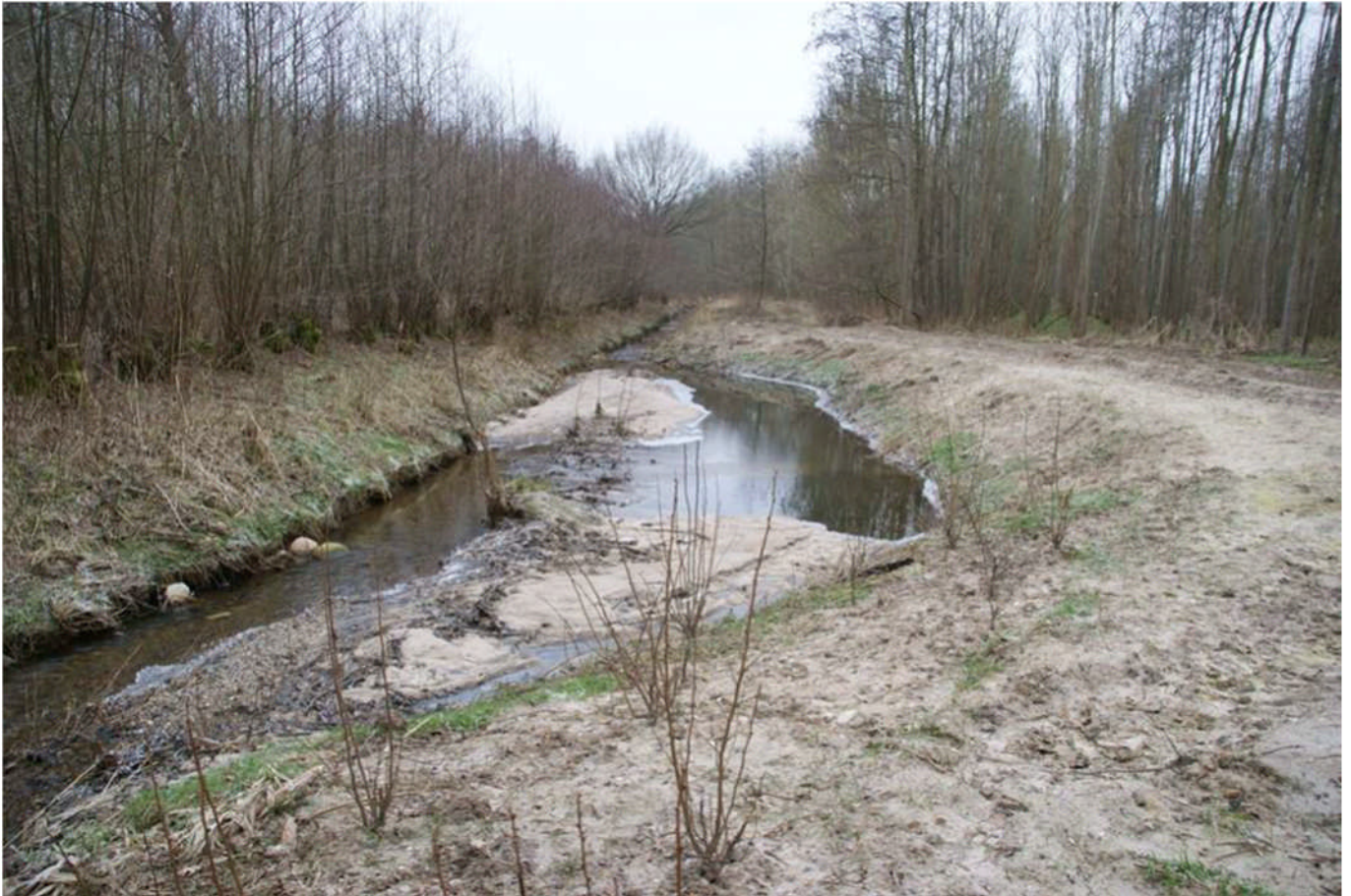
ABBILDUNG 18: SANDFANG AN DER OHLAU (SCHLESWIG-HOLSTEIN) (GEWÄSSERPFLEGEVERBAND OHLAU 2014)
