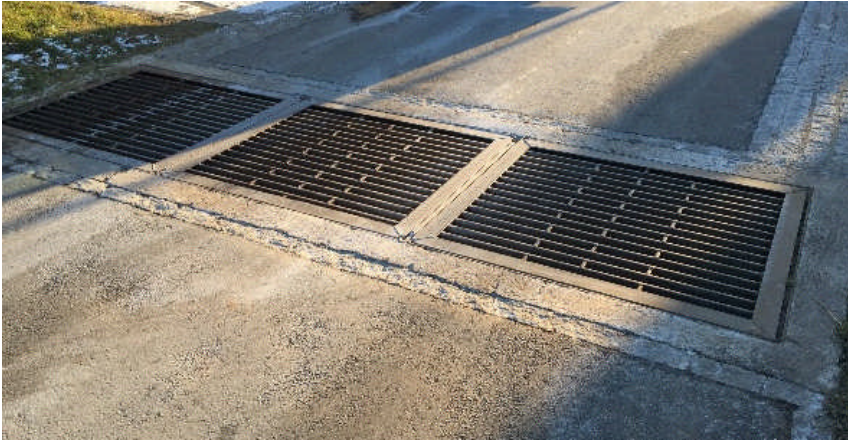
ABBILDUNG 16: BREITFLÄCHIGER EINLAUF IN L-EVERLINGEN (FOTO INCA, 2022)
