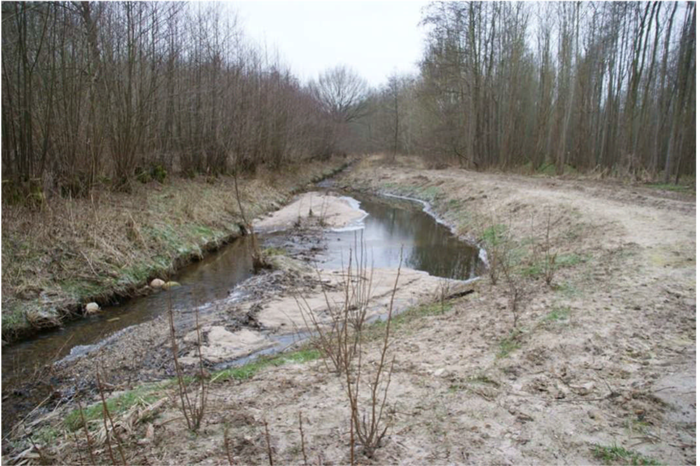
ABBILDUNG 18: SANDFANG AN DER OHLAU (SCHLESWIG-HOLSTEIN) (GEWÄSSERPFLEGEVERBAND OHLAU 2014)
