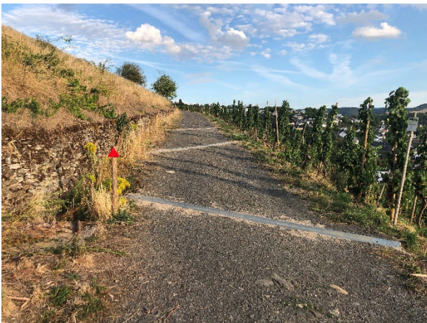
ABBILDUNG 23: MEHRFACHE KLEINRÄUMIGE WEGEABSCHLÄGE (FOTO INCA,03.09.2022)
