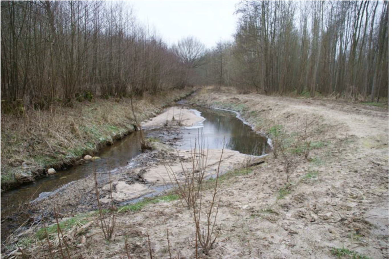
ABBILDUNG 18: SANDFANG AN DER OHLAU (SCHLESWIG-HOLSTEIN) (GEWÄSSERPFLEGEVERBAND OHLAU 2014)
