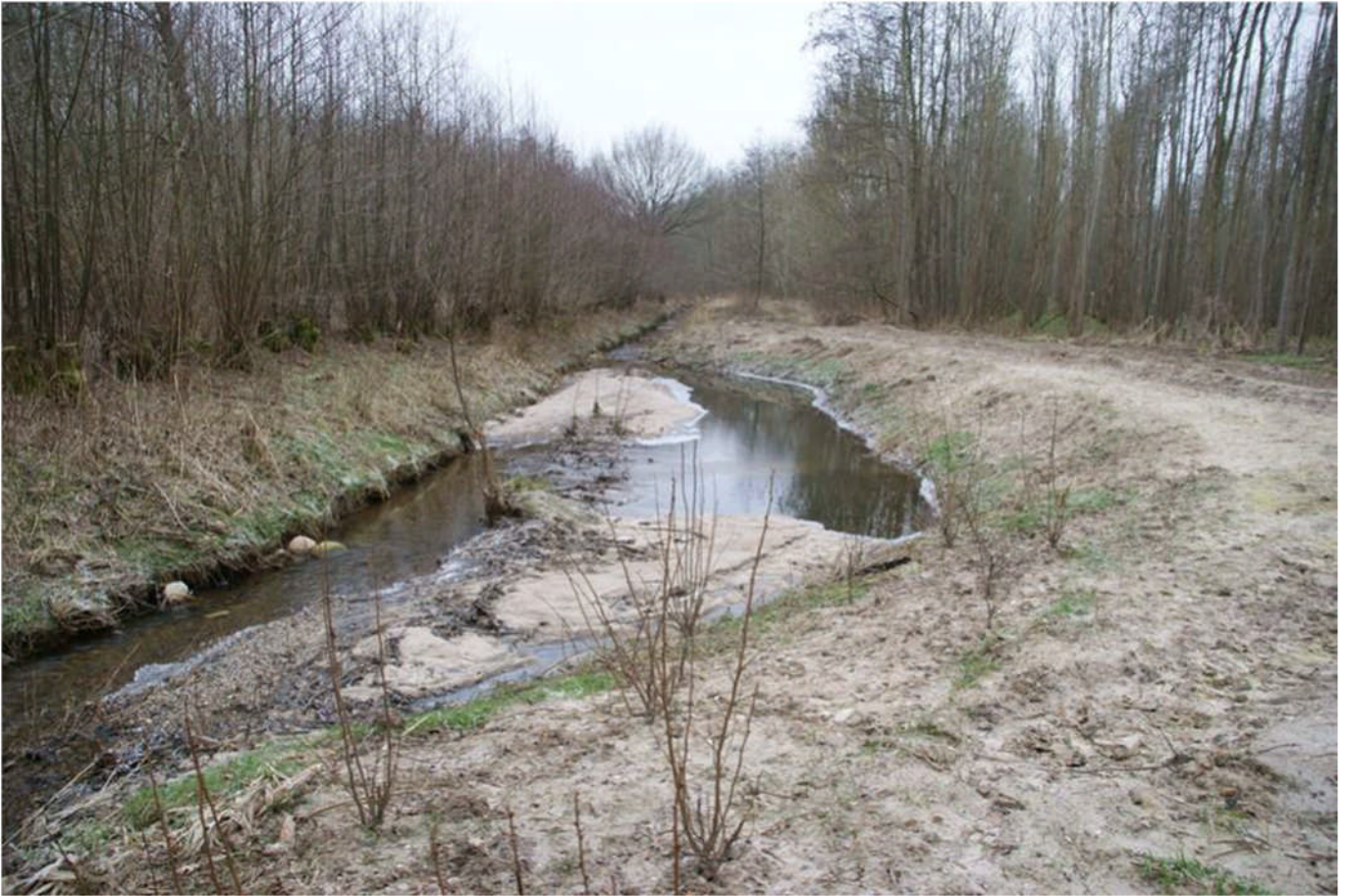
ABBILDUNG 18: SANDFANG AN DER OHLAU (SCHLESWIG-HOLSTEIN) (GEWÄSSERPFLEGEVERBAND OHLAU 2014)
