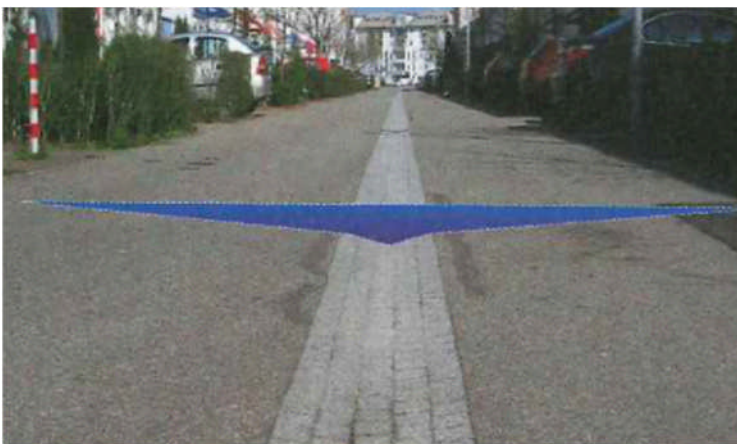
ABBILDUNG 28: STRASSE MIT INVERSEM DACHPROFIL (DWA, 2013)
